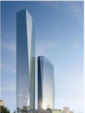
La Roca Edifice-India
